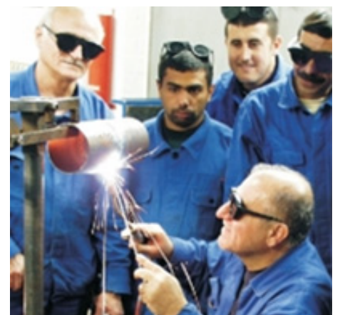
Gasschweißen am Rohr in Zwangslage
